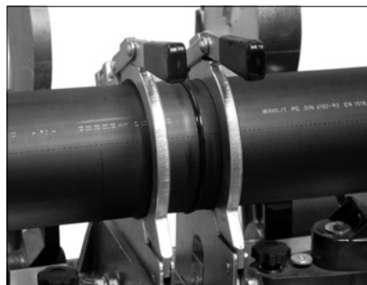
Охлаждение сварного шва
