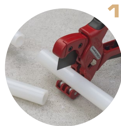
1 отрезать трубу нужной длины
